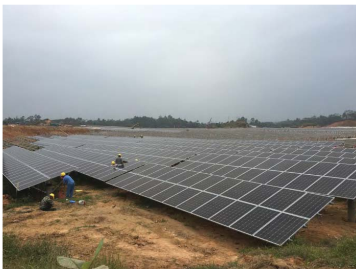
安装光伏组件
