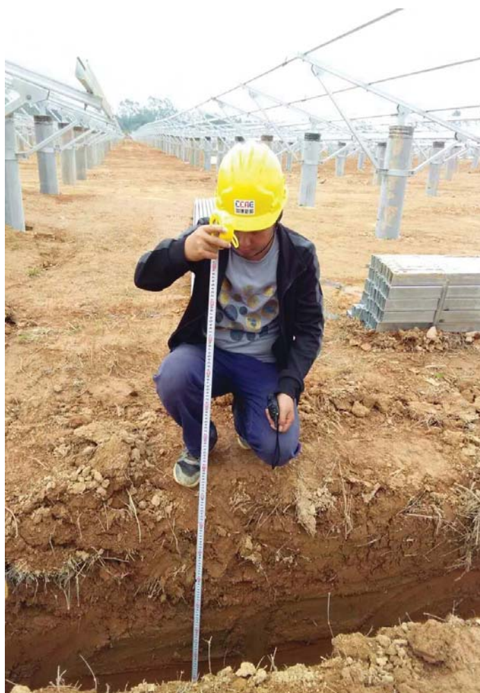
挖接地扁铁沟
