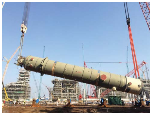
大型设备吊装
