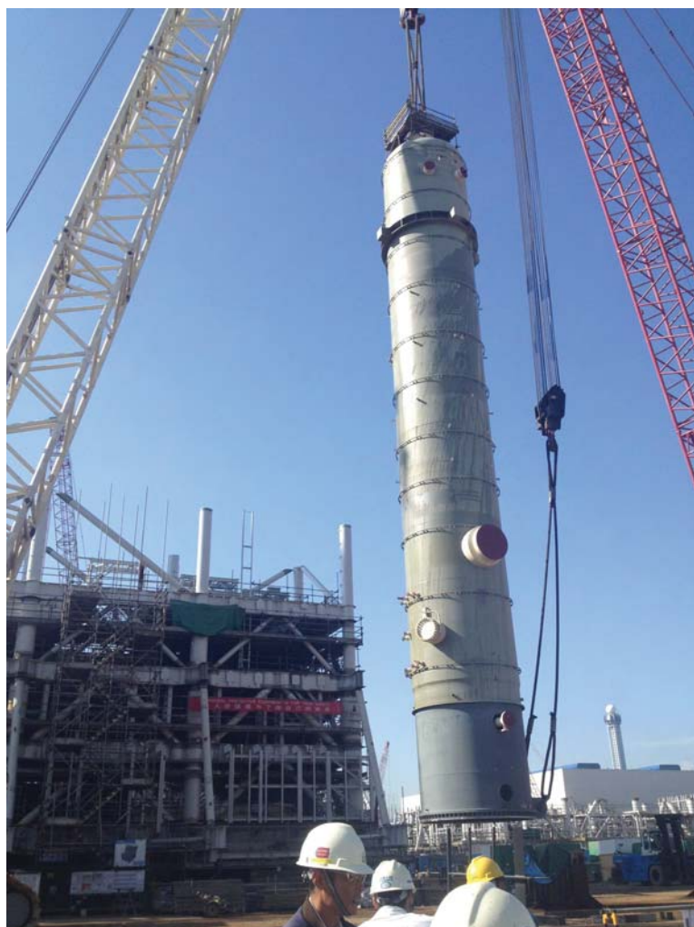
项目最大设备吊装 step3
