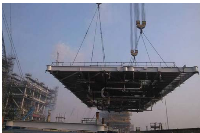
甲板片一体化建造吊装
