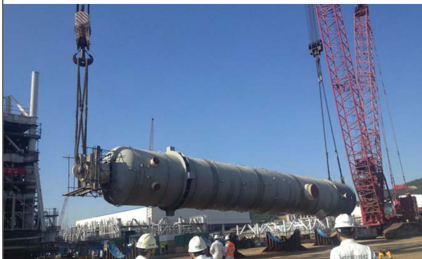
项目最大设备吊装 step1
