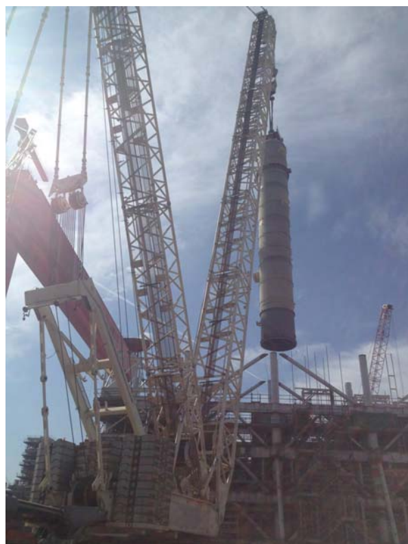
项目最大设备吊装 step4
