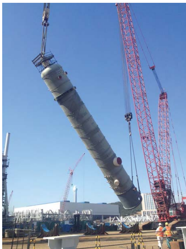
项目最大设备吊装 step2
