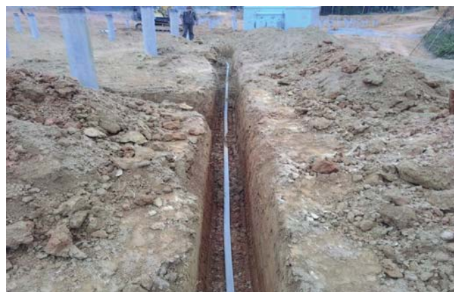
接地扁铁挖沟及埋置
