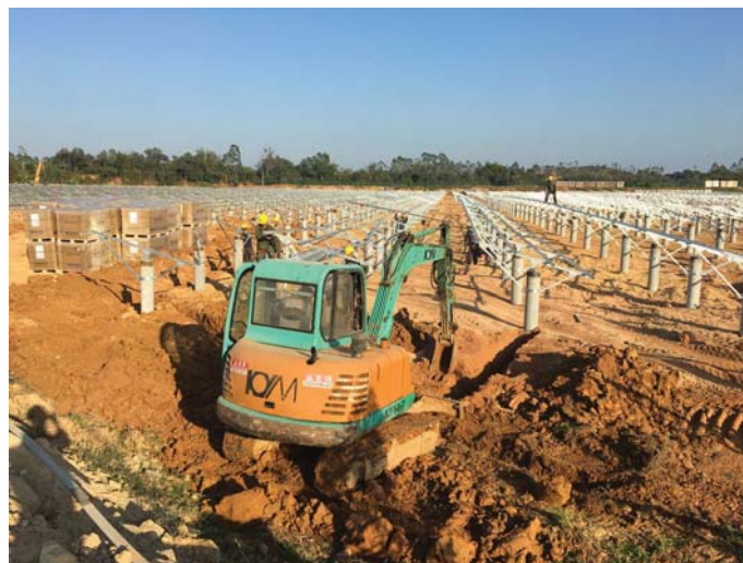
接地扁铁挖沟
