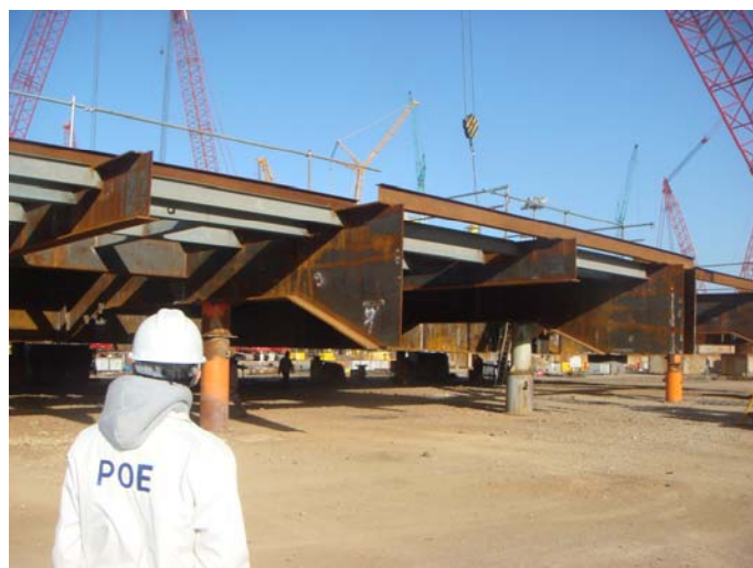
13#甲板片顶升作业完成
