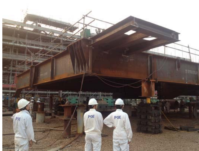
6#甲板片预制完成顶升作业
