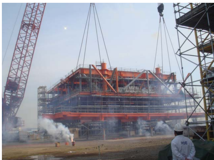
JX1-1 WHPB/M组块 现场总组吊装
