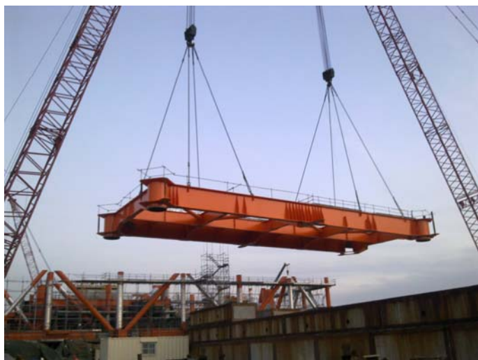
12# 甲板片吊装总组作业
