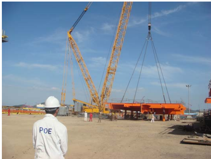
6# 甲板片吊装总组作
