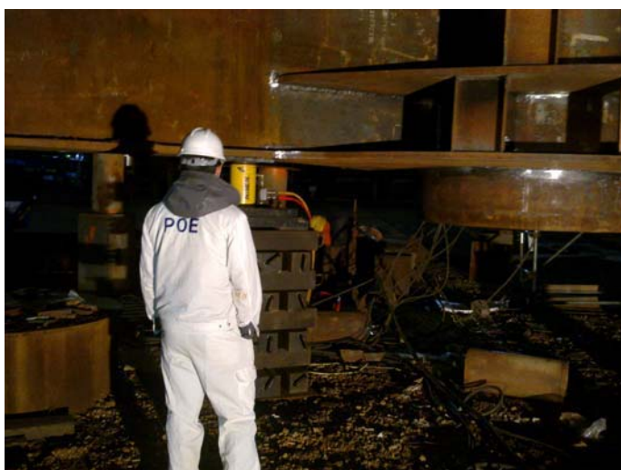
14#甲板片预制完成顶升作业
