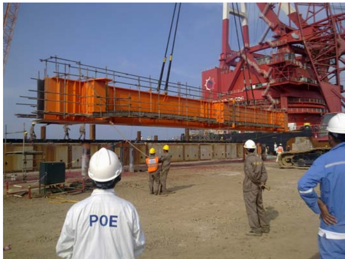
滑道梁吊装总组安装
