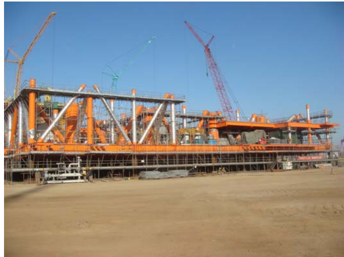
LF7-2 DPP组块 29米以下立柱拉筋安装
