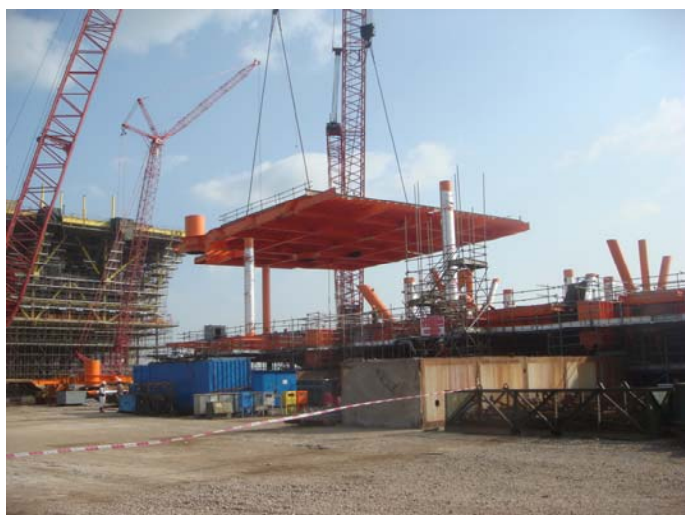
11# 甲板片吊装总组作业
