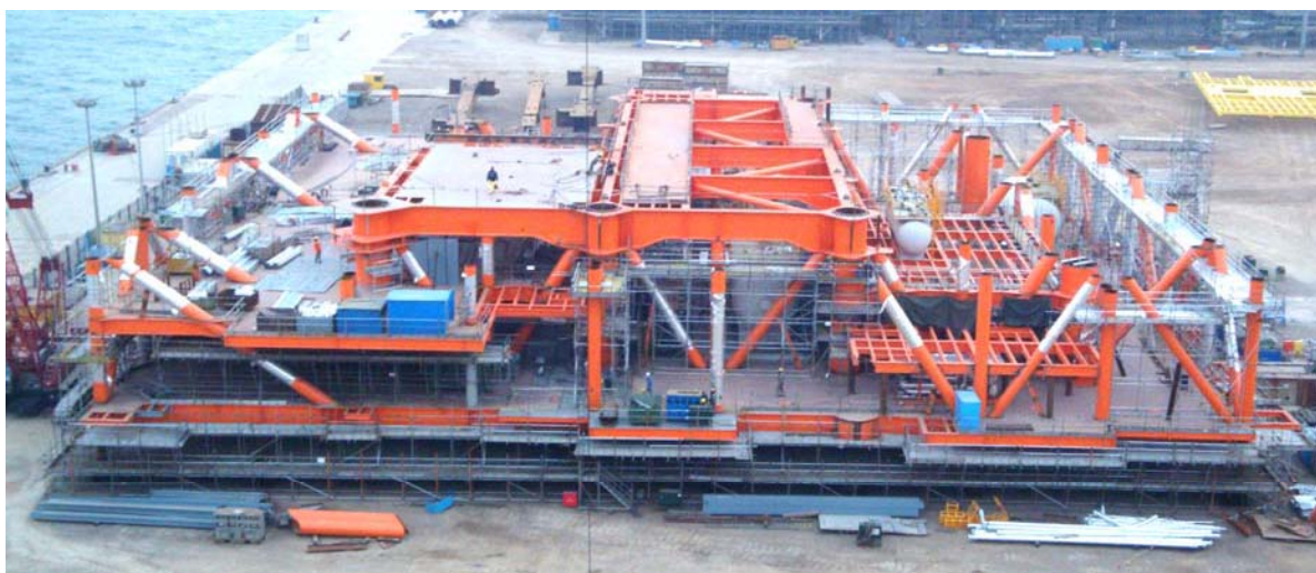
LF7-2 DPP组块 19米甲板片、24米甲板片、29米部分甲板片总组安装完成
