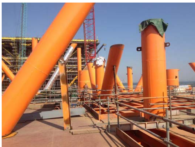
LF7-2 DPP组块 19米以上立柱拉筋安装
