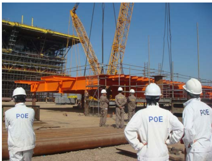
4# 甲板片吊装总组作业
