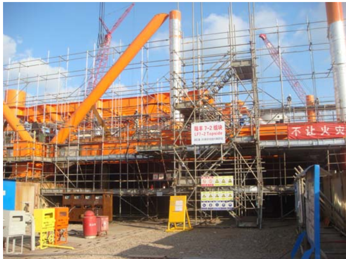
LF7-2 DPP组块 19米以上立柱拉筋安装
