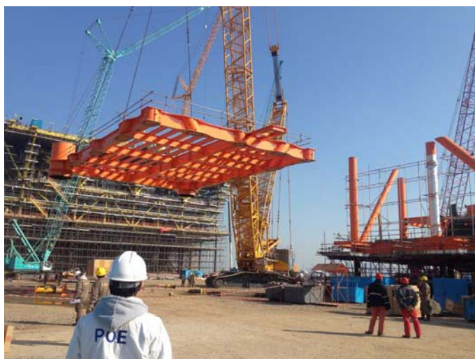
8# 甲板片吊装总组作业
