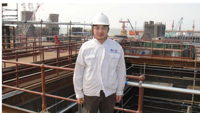
海水淡化PT模块结构顶部
