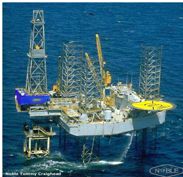
图1 自升式钻井平台
