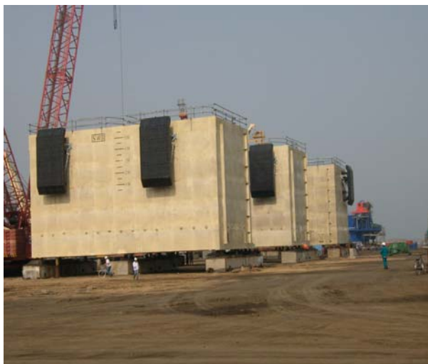
海水淡化 CAISSON场地建造完成
