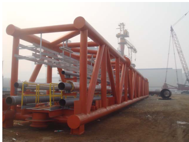
SZ36-1WHPK组块栈桥
