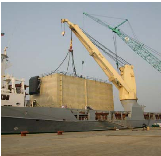
海水淡化 CAISSON装船
