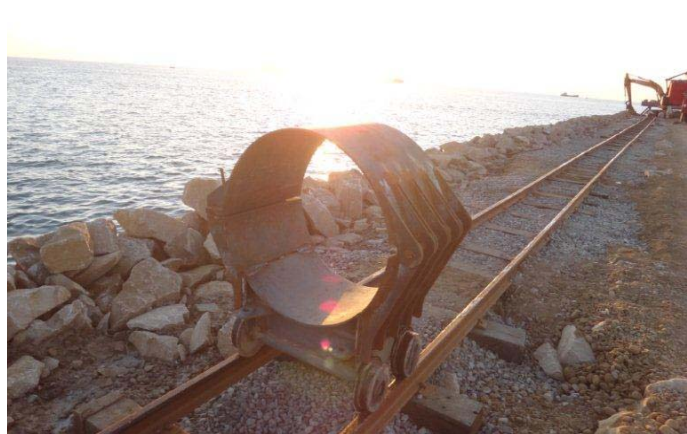
围堰-钢轨铺设
