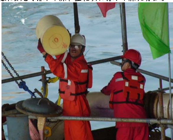
蓬莱曹妃甸排水干燥和堕化项目施工现场
