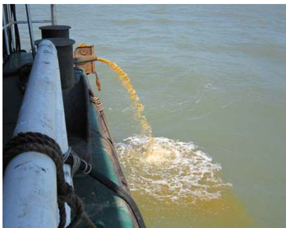
蓬莱曹妃甸排水干燥和堕化项目排水干燥现场
