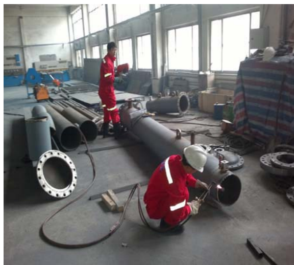
蓬莱曹妃甸排水干燥和堕化项目收发球筒预制现场
