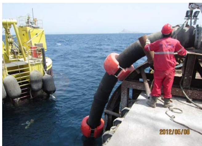
单点水下软管入水
