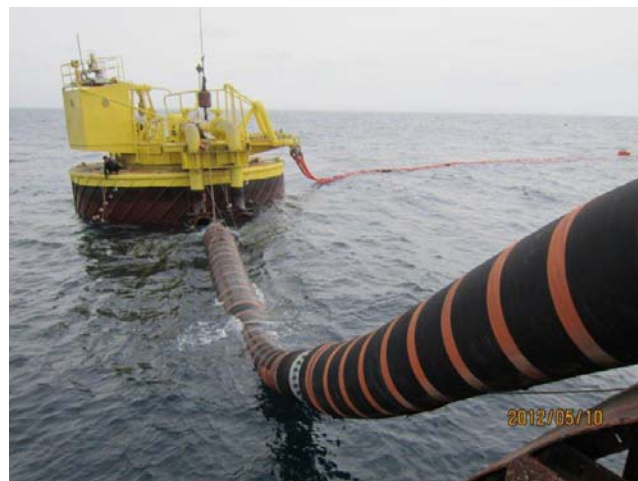
漂浮软管连接入水
