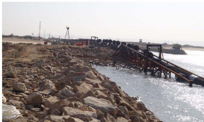
围堰-入水桥安装完成
