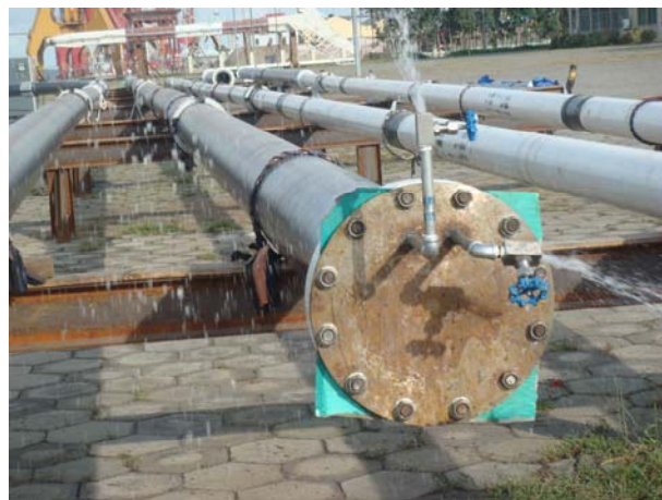
现场33Mpa试压结束排水
