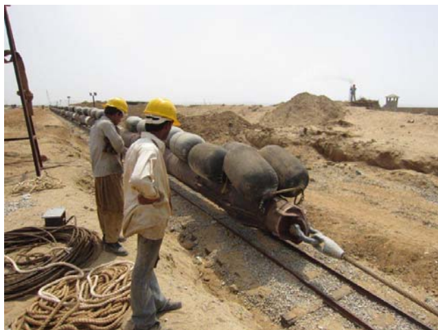
第二段管线准备拖拉
