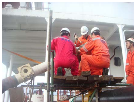
海上试压封头安装
