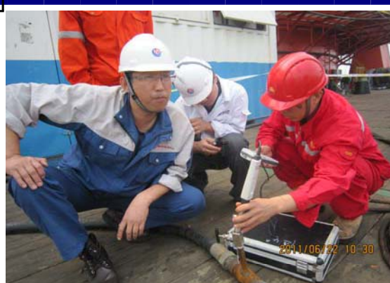
蓬莱曹妃甸排水干燥和堕化项目试压现场
