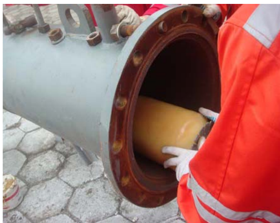
现场清管、测径球安装
