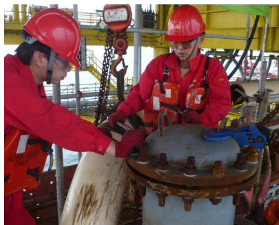
蓬莱曹妃甸排水干燥和堕化项目气密度试验
