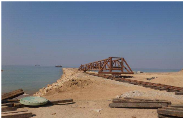
围堰-入水桥运输
