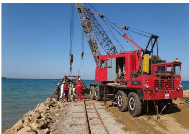
围堰-入水桥安装
