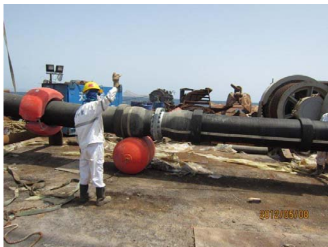
单点海底软管连接
