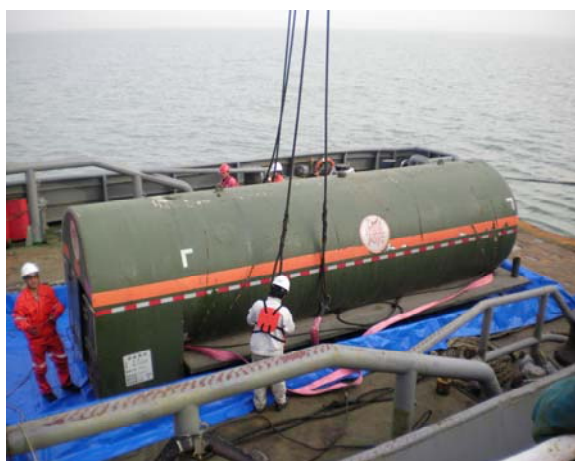
蓬莱曹妃甸排水干燥和堕化项目出海充氮现场
