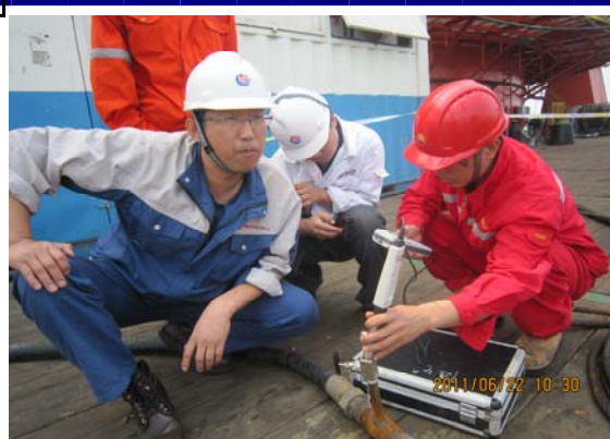
蓬莱曹妃甸排水干燥和堕化项目试压现场
