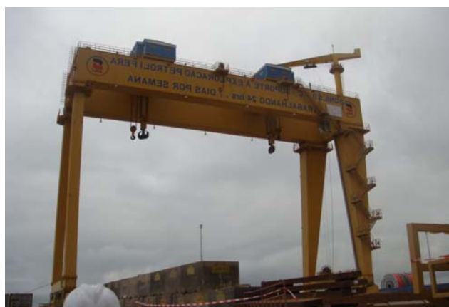
安哥拉项目顺利完工
