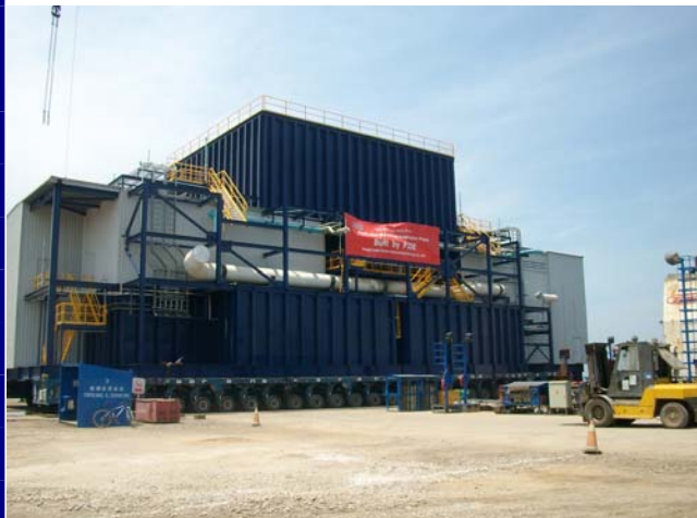
海水淡化项目PH模块顺利完工
