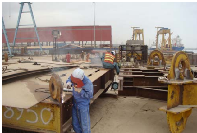
安哥拉项目现场焊接
