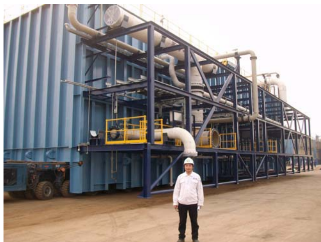
海水淡化项目PT模块小车运输
