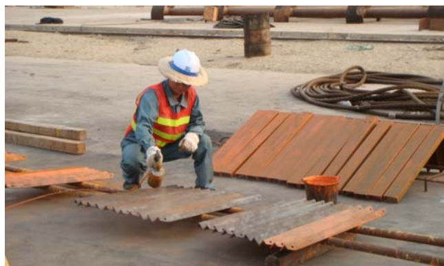
安哥拉项目现场喷涂
