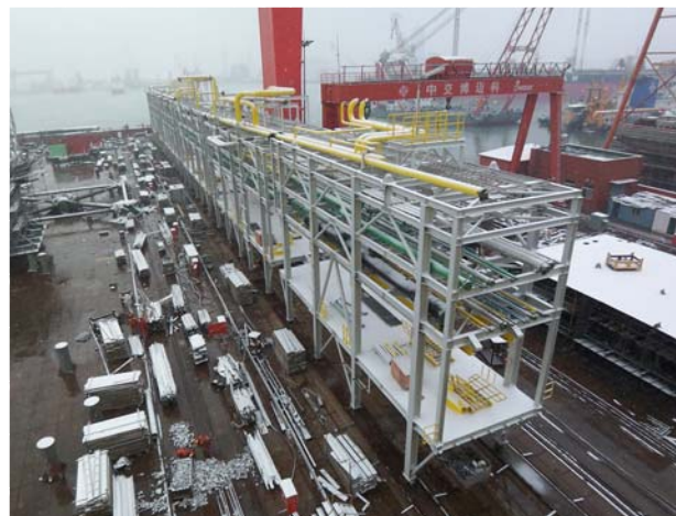
Piperack 施工现场
