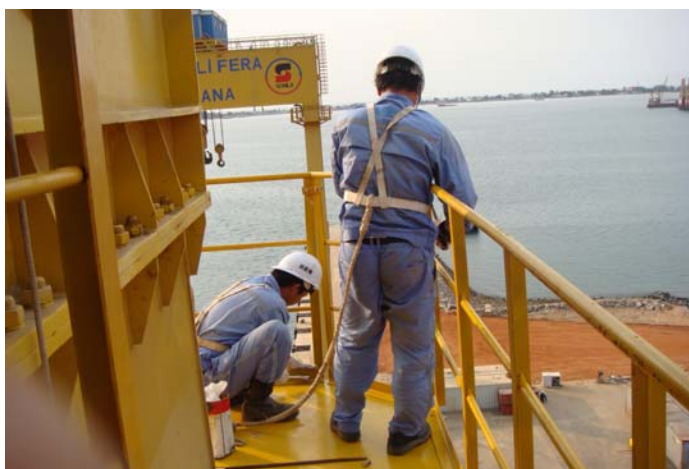
安哥拉项目现场安装
