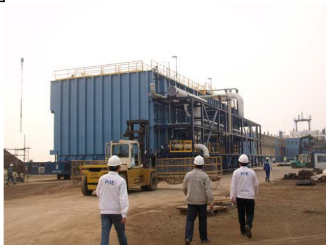
海水淡化项目施工现场
