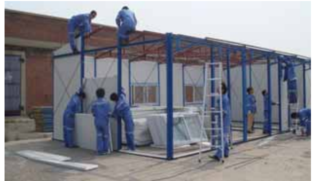
POE工人正在试装安哥拉海管项目的活动板房
